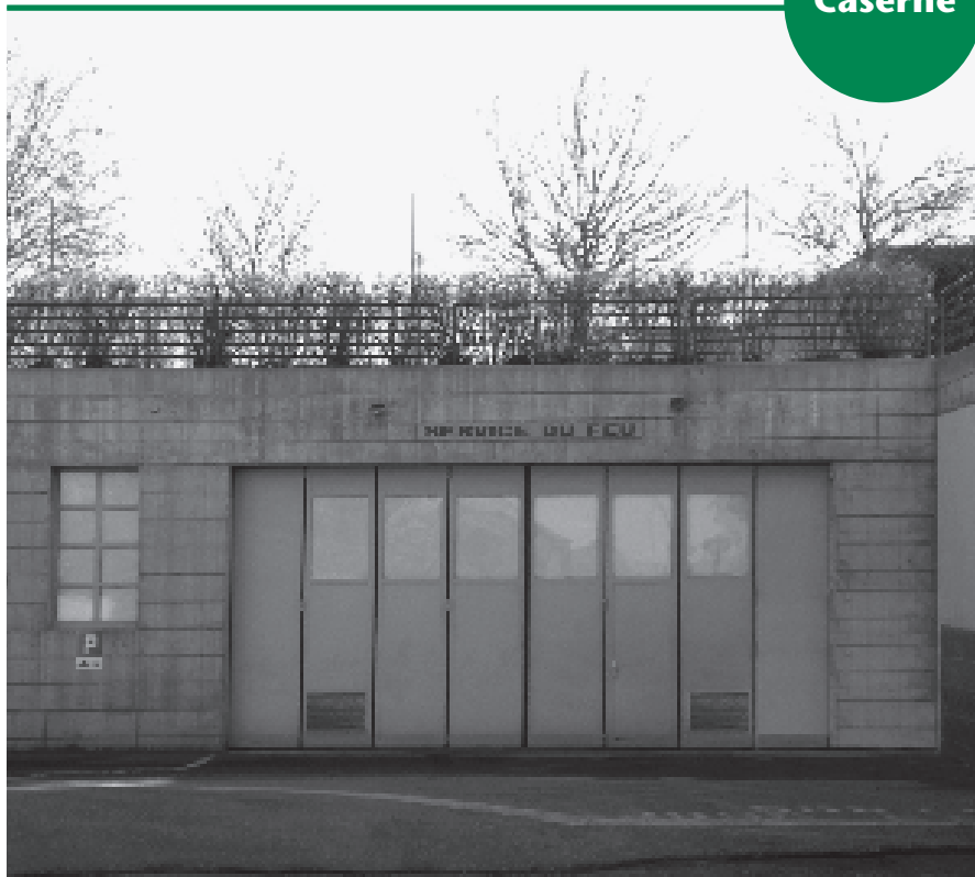
La caserne des sapeurs-pompiers volontaires de Bernex se situe actuellement à côté de la mairie.
