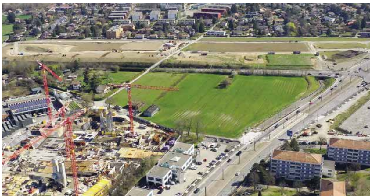
Chantier du quartier de Saint-Mathieu et périmètre de la «Goutte de Saint-Mathieu»
