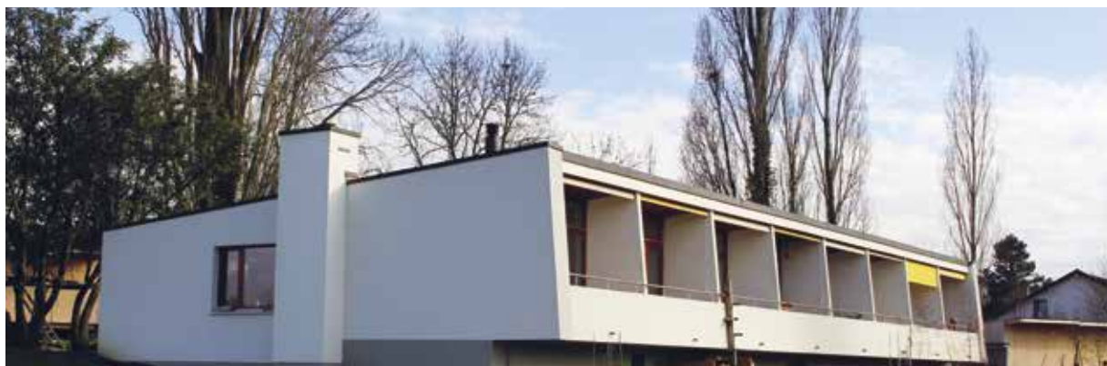
Immeuble chemin des Blanchards 46, construit en 1961 par les architectes Charles, Eric et André Billaud.
