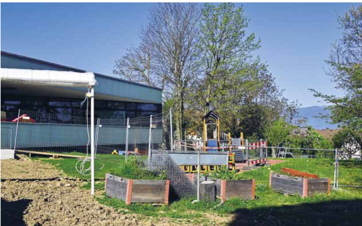
Travaux d'agrandissement du préau et de l'espace extérieur de la crèche.
