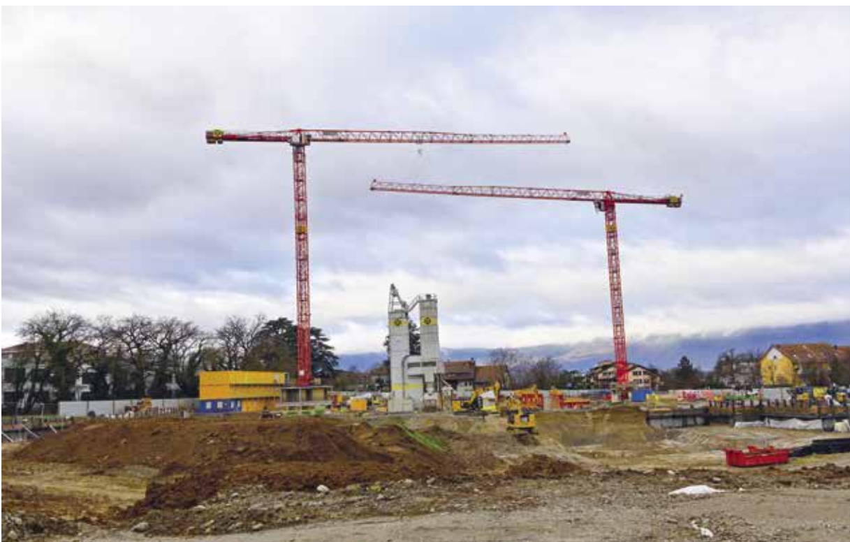
Démarrage du chantier de Saint-Mathieu
