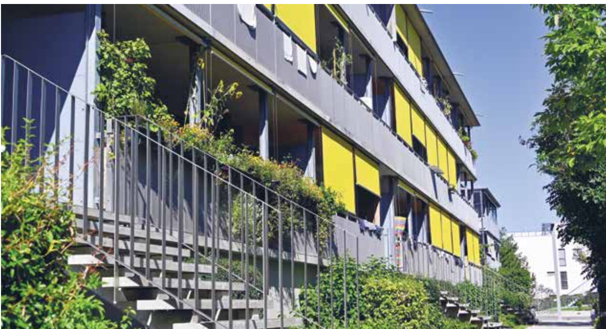
Immeuble chemin de Carobot à Cressy.
