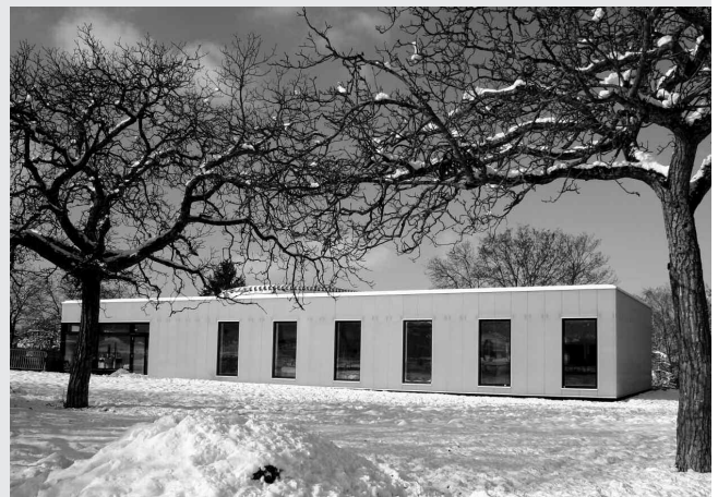
La nouvelle crèche MINERGIE de Bernex
